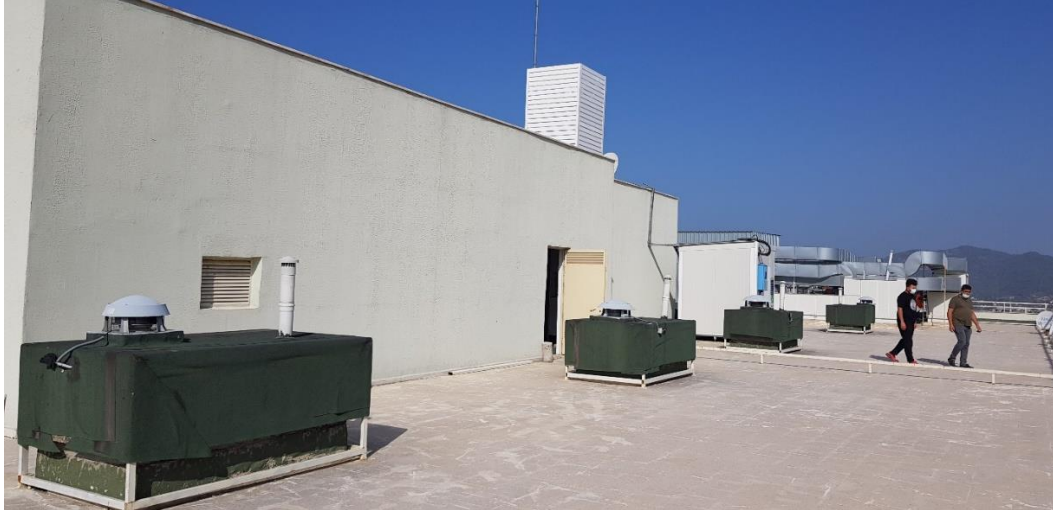
Fotoğraf 2. Gazipaşa Devlet Hastanesi Çatı Fotoğrafi
